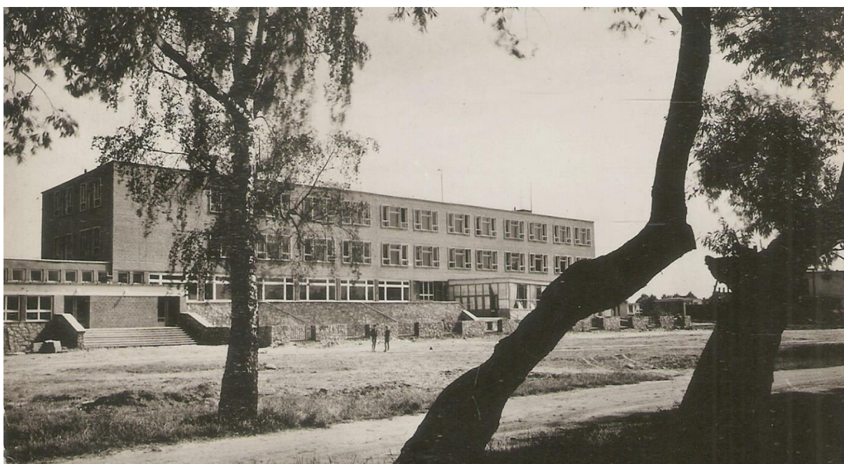
Pierwsza szkoła „tysiąclatka” w Gdańsku; nowoczesna forma połączona z tradycyjnym materiałem – cegłą, wyróżnia budynek w otoczeniu
