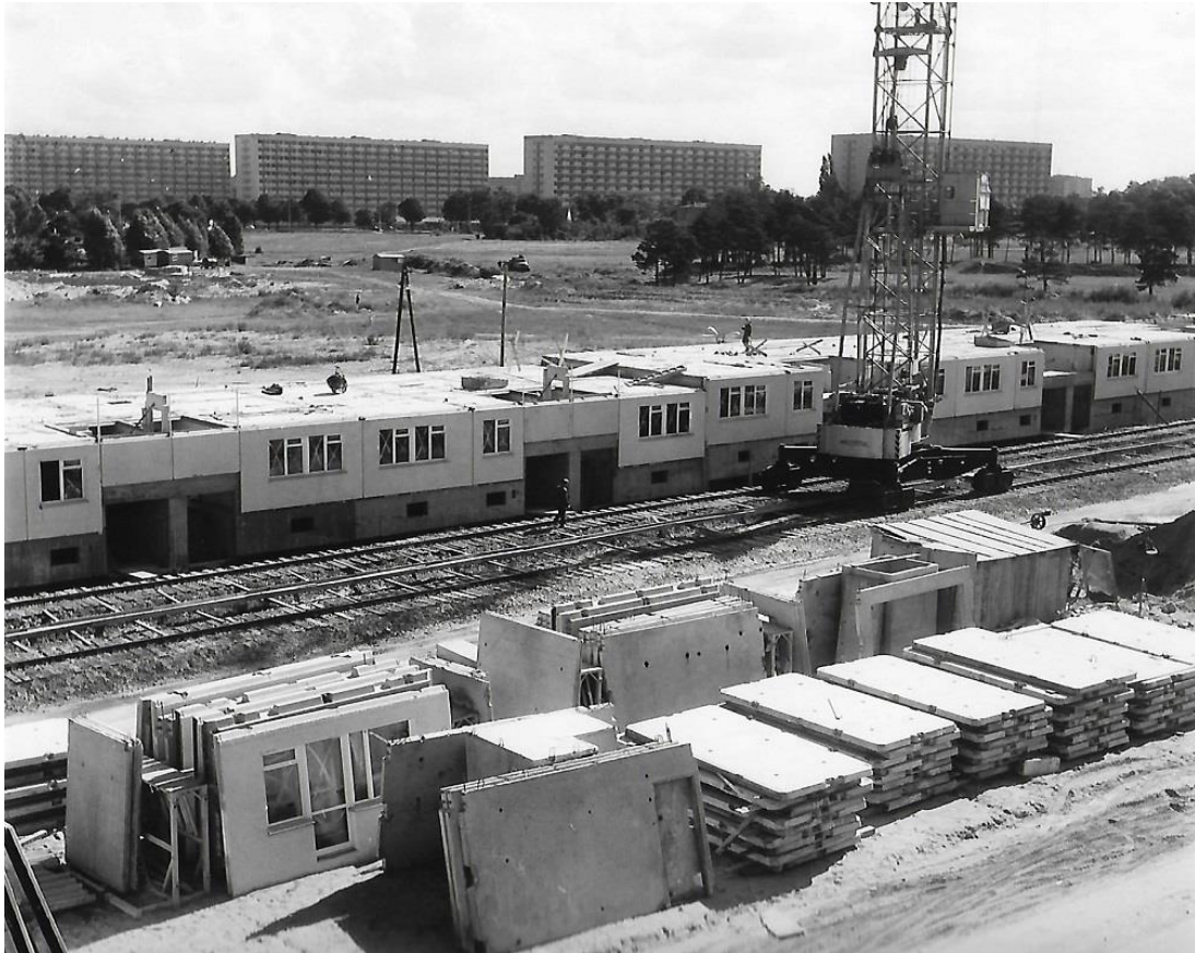
Budowa Żabianki z elementów produkowanych w „fabryce domów”, w głębi osiedle Pomorska I
