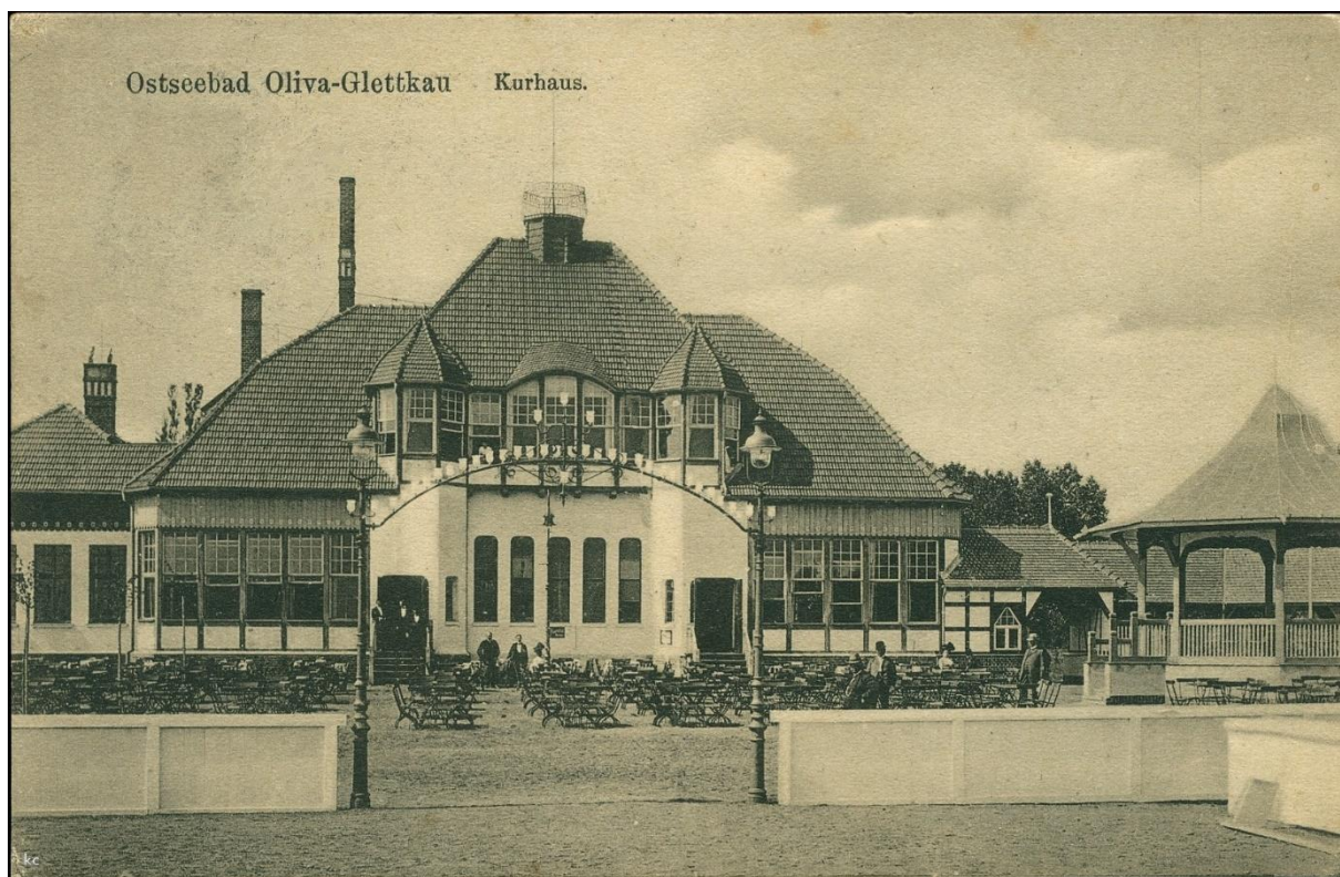
Dom Zdrojowy z tarasem, zachowany w zmienionej, skromniejszej formie
