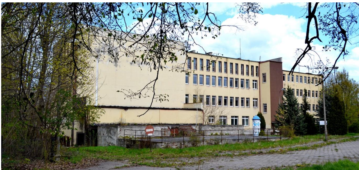
Budynek szkoleniowy PZPR, później Wydział Psychologii UG, rozebrany w 2020; w jego miejscu powstało zamknięte osiedle
