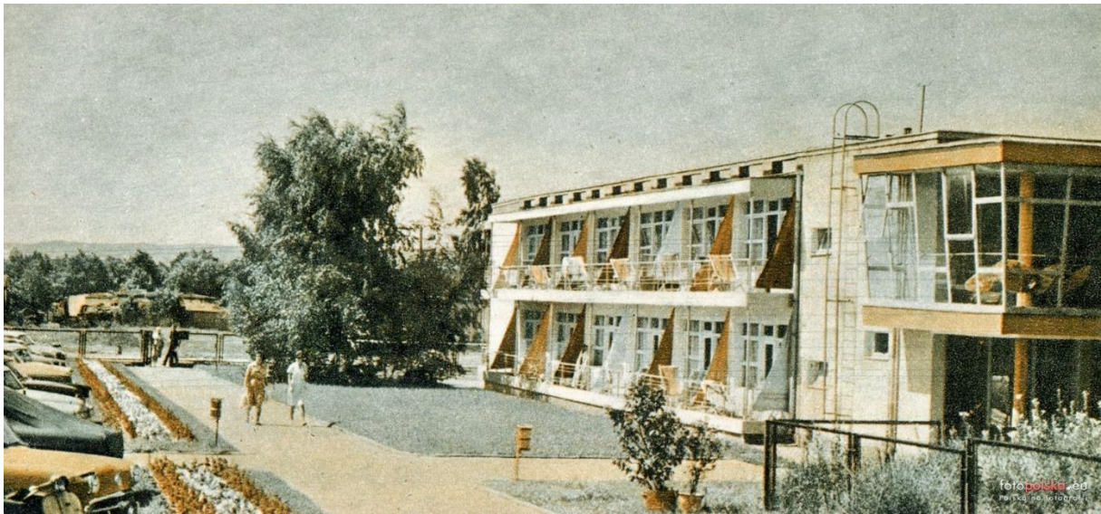
Jeden z pawilonów mieszkalnych ośrodka Rzemieślnik przed przebudową
