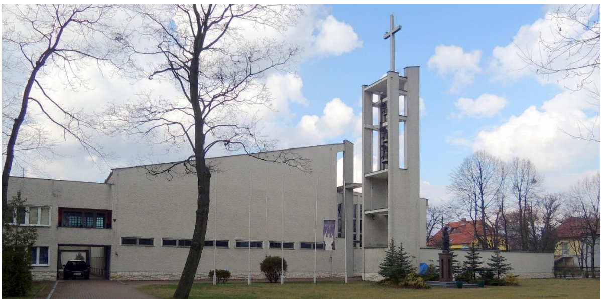
Kościół pw. św. Piotra i Pawła zbudowany w miejscu wyburzonej kapliczki z 1926 roku
